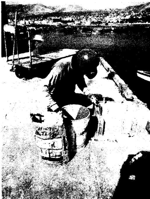
Mortero nivelante eje 1
