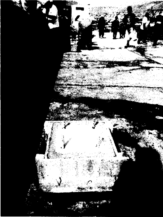
Plancha base instalada con mortero nivelante
